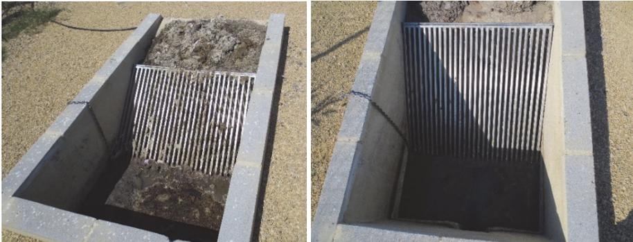
**Figura 3.1. Imágenes de la reja de finos en la entrada a la EDAR de Carrícola (Valencia, España). A la izquierda se observa un grado de colmatación en torno al 30%, a la derecha la reja tras limpieza manual. Fuente: elaboración propia**
