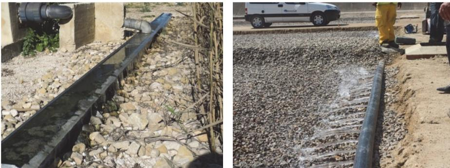
**Figura 5.2. Imágenes de canal de vertido liso (izquierda) y tubería perforada (derecha) para distribución de agua en la entrada al humedal.** Fuente: elaboración propia
