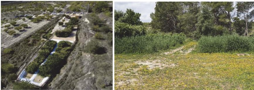
**Figura 5.1. Imágenes de humedales de flujo subsuperficial horizontal en Planes (Alicante) (izq) y Carrícola (Valencia) (dcha).** Fuente: imagen de EDAR en Planes EPSAR, imagen de EDAR de Carrícola propia
