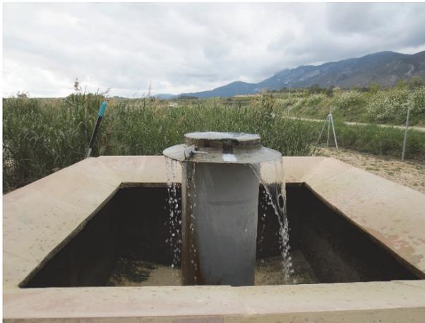
**Figura 4.1.** Arqueta de reparto de agua con canalización ascendente actuando de “fuente” en EDAR de Carrícola (Valencia, España). Fuente: elaboración propia
