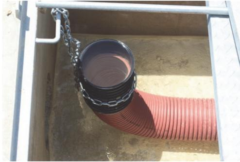
**Figura 5.3. Imagen de tubo flexible en la arqueta de salida de un humedal de flujo subsuperficial horizontal.** Fuente: elaboración propia
