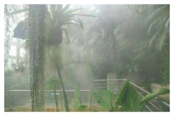
Fig. 11.1.1 Sistema de humectación de un recinto de plantas de interior. El sistema es de agua a presión sin aire comprimido.
