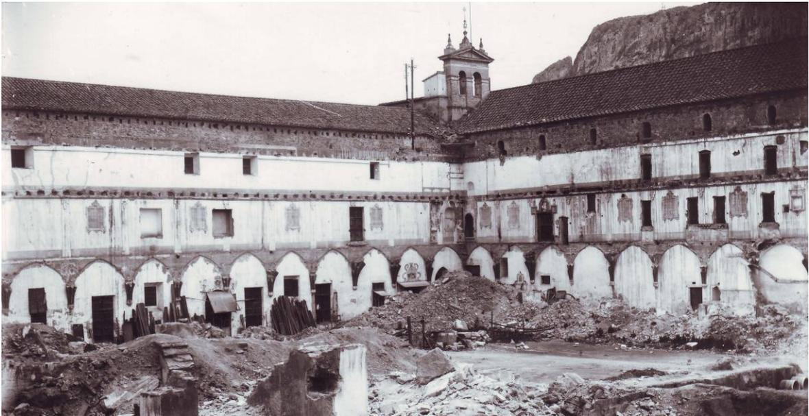
Se desconoce la naturaleza de la cubierta original. En la actualidad, el plano de evacuación está formado por una techumbre a un agua mediante pares formados por viguetas de hormigón, pero se desconoce si imita una solución anterior o sustituye a otra diferente.
