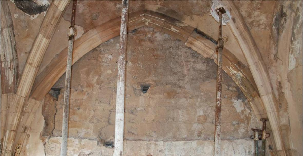
**Claves.** La clave polar está decorada con un florón que incluye el escudo de Aragón en losange. Como en otras bóvedas similares, su construcción difiere de los ejemplos de piedra. La pieza fue conformada a posteriori, a partir del cruce de los arcos diagonales, con el añadido de un medallón prefabricado que, a diferencia de otros ejemplos, en este caso se descuelga con mayor limpieza sin ocultar las aristas generadas por la intersección de los nervios.
