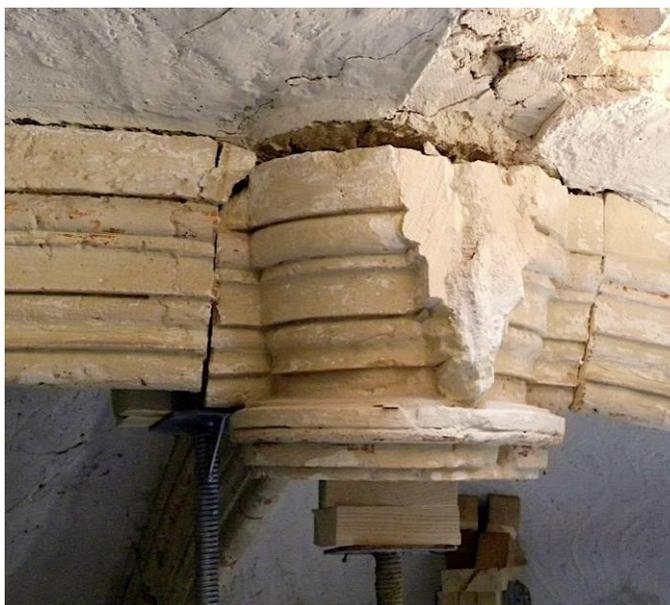
cualquier ligero cedimiento de los apoyos producido, por ejemplo, por un leve giro de uno o dos grados en los estribos, inapreciable a simple vista, puede originar movimientos de decímetros.
