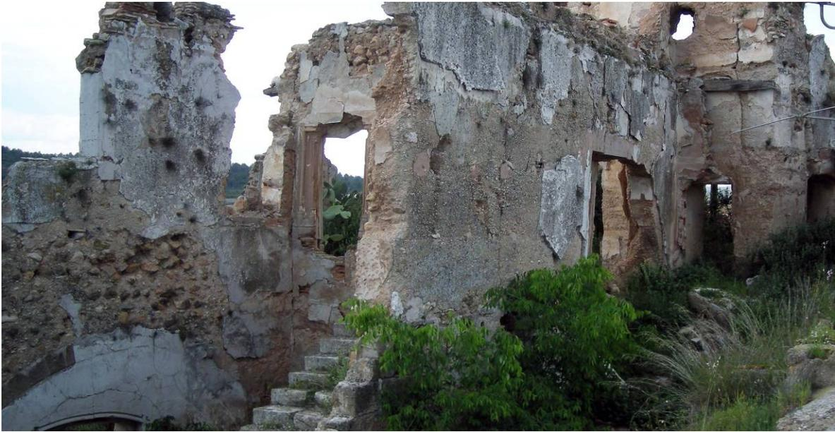
En todas las fases constructivas del palacio, que ocupa una superficie de 568 m<sup>2</sup> dentro de un recinto amurallado de unos 1500 m<sup>2</sup>, predomina el sistema constructivo de albañilería: muros de mampostería y tapial, bóvedas tabicadas y elementos de yeso.
