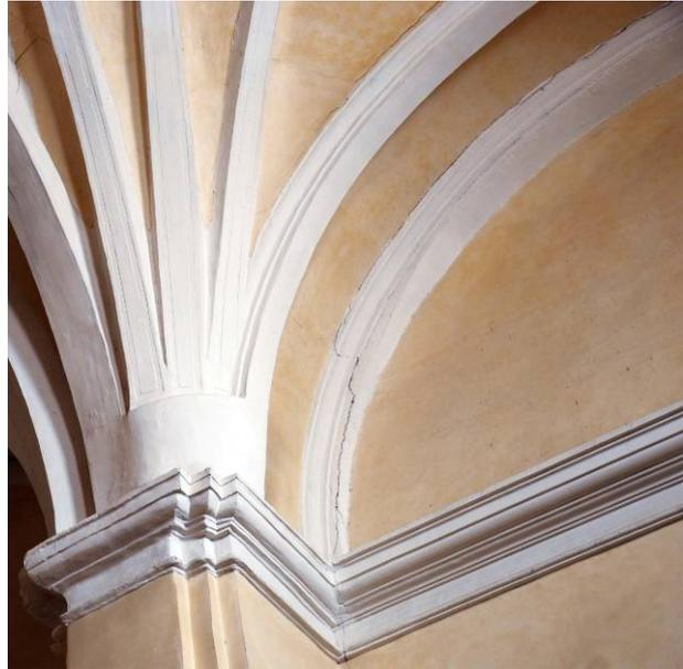
Todos los nervios de la bóveda de nueve claves tienen igual aspecto y dimensiones. Parecen haber sido elaborados mediante piezas macizas de yeso, aunque no se pueden distinguir las juntas del dovelaje por hallarse revestidos actualmente. En estos momentos su sección es triangular, de 0,20 m de canto (un palmo). Aunque cabe sospechar que tuviesen molduración renacentista, este aspecto no ha podido ser comprobado.
