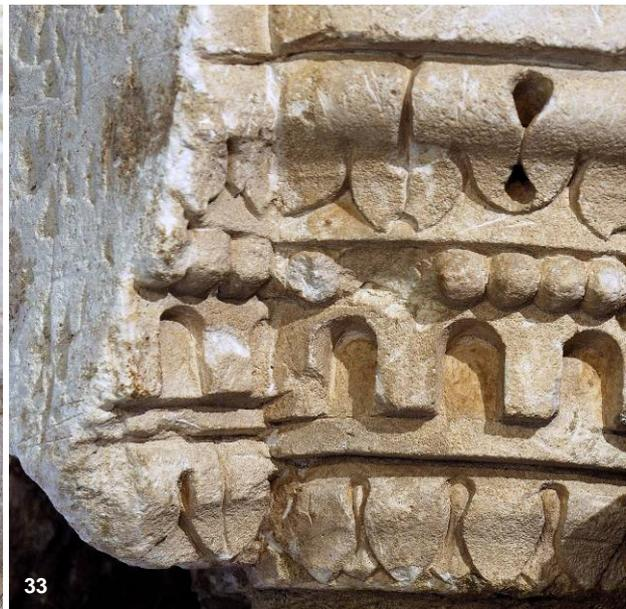
llas o punzones. La incisión tan marcada que se aprecia en las intersecciones entre superficies, las huellas del replanteo de cotas o cambios de concavidad o la proximidad al formato cúbico de algunas perlas dan fe de ello. También refuerza esta hipótesis la uniforme sinuosidad de las tramas de hojas de acanto, particularmente las del primer nivel, en las que ha perdurado la huella del replanteo y la evidente definición de las perlas o cuentas a partir de la talla previa de cilindros.
