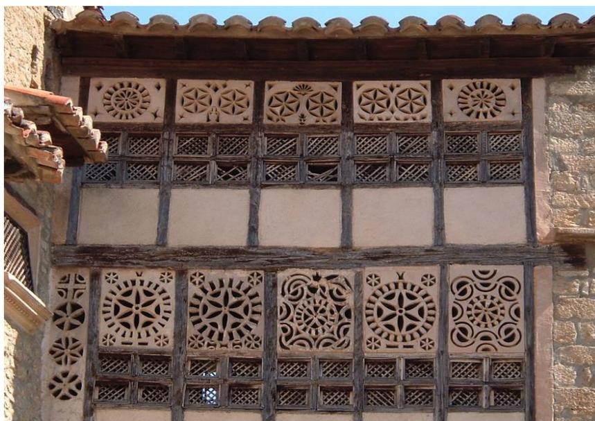
las tensiones hacia los puntos resistentes de la fábrica. Cuando las dimensiones aumentaban o el calado de la sección la volvía muy frágil podían incorporarse soportes de ladrillo o madera.
