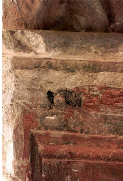
32. Vivienda del bachiller Martínez de Robles. A la izquierda, cuña de madera empleada para nivelar el asiento del arranque del arco. A la derecha, cuña de madera para el asiento del capitel sobre la pilastra de la galería.
