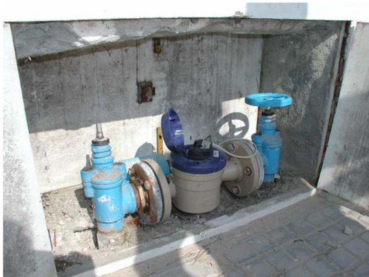
FIGURA 5. INSTALACIÓN DE UNA CONTADOR DE CHORRO ÚNICO JUNTO CON UNA VÁLVULA DE COMPUERTA AGUAS ARRIBA SIN MANTENER TRAMOS RECTOS DE TUBERÍA.
