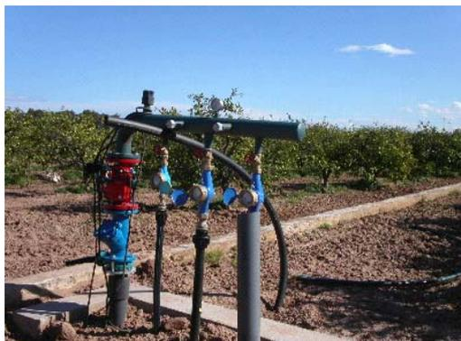
FIGURA 2. INSTALACIÓN TÍPICA DE UN HIDRANTE DE RIEGO.
