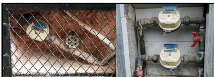
FIGURA 1. INSTALACIÓN INCLINADA DE LOS CONTADORES DE AGUA.
