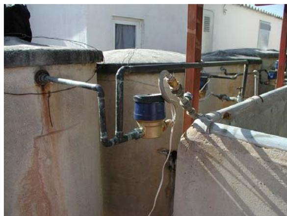
FIGURA 6. PRESENCIA DE DEPÓSITOS DE ALMACENAMIENTO EN LAS INSTALACIONES INTERIORES
