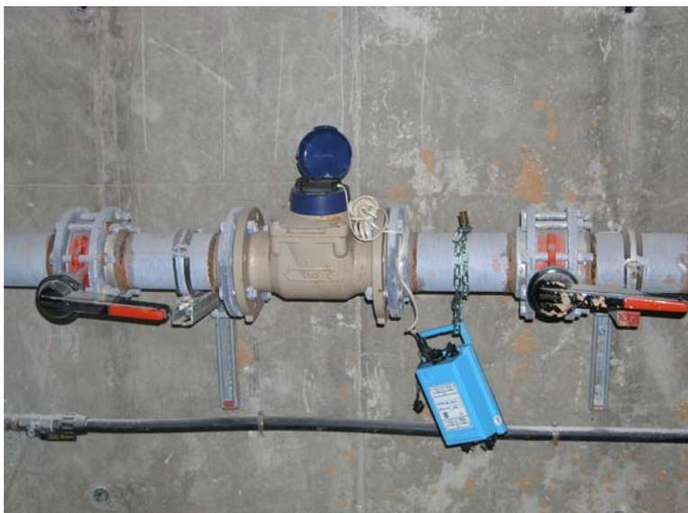
FIGURA 1. INSTALACIÓN DE UNA CONTADOR WOLTMAN JUNTO A UNA VÁLVULA DE MARIPOSA.
