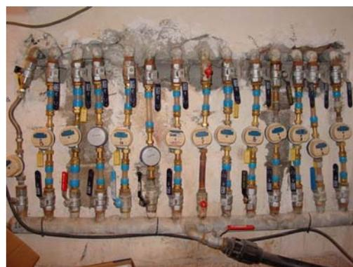
FIGURA 3. BATERÍA DE CONTADORES DOMÉSTICOS INSTALADOS EN POSICIÓN VERTICAL.
