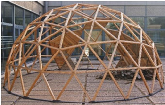
*Imagen 5. Cúpula Geodésica 4v, instalada en la ETSIE*
