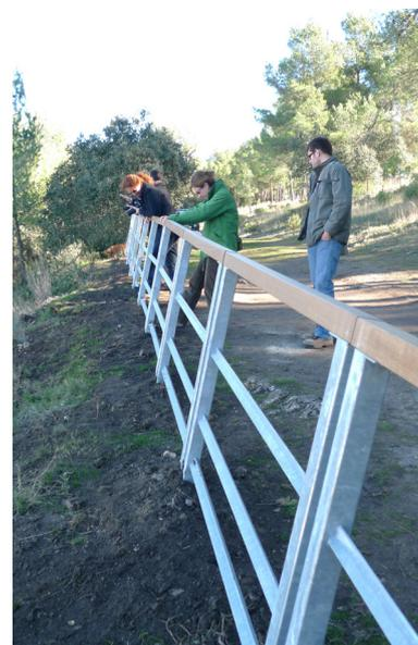
Pasamanos fijado a un paramento irregular. El diseño de los anclajes debe garantizar que la separación entre el pasamanos y el paramento sea la adecuada para evitar rozaduras.
