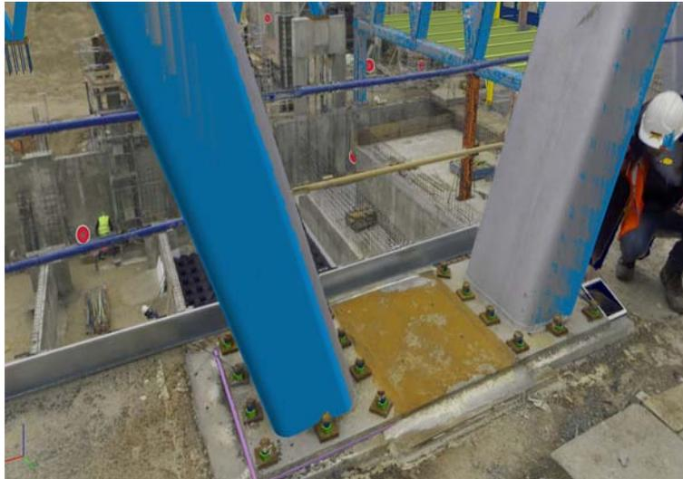
Figura 4. Superposición de modelo teórico con nube de puntos e imágenes HDR georreferenciadas. Fuente: Becsa (2021)
