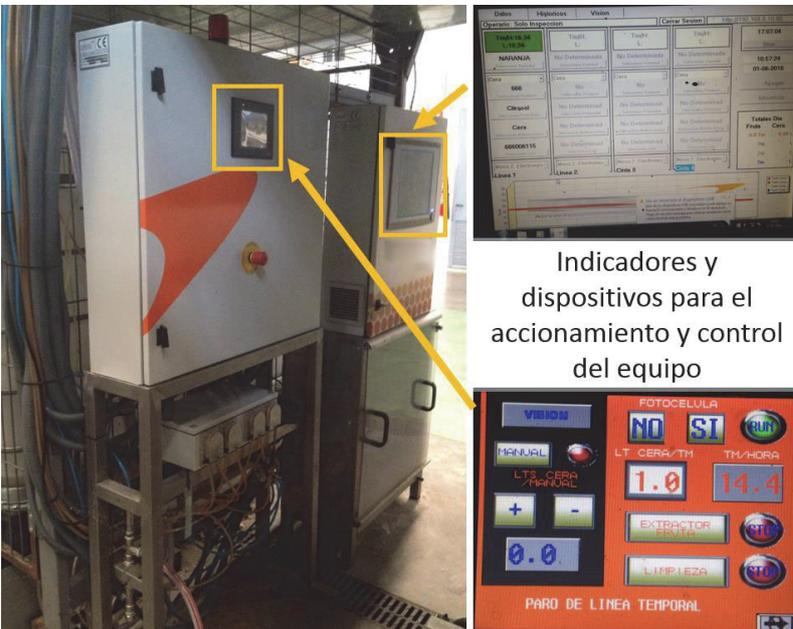
Indicadores y dispositivos para el accionamiento y control del equipo
