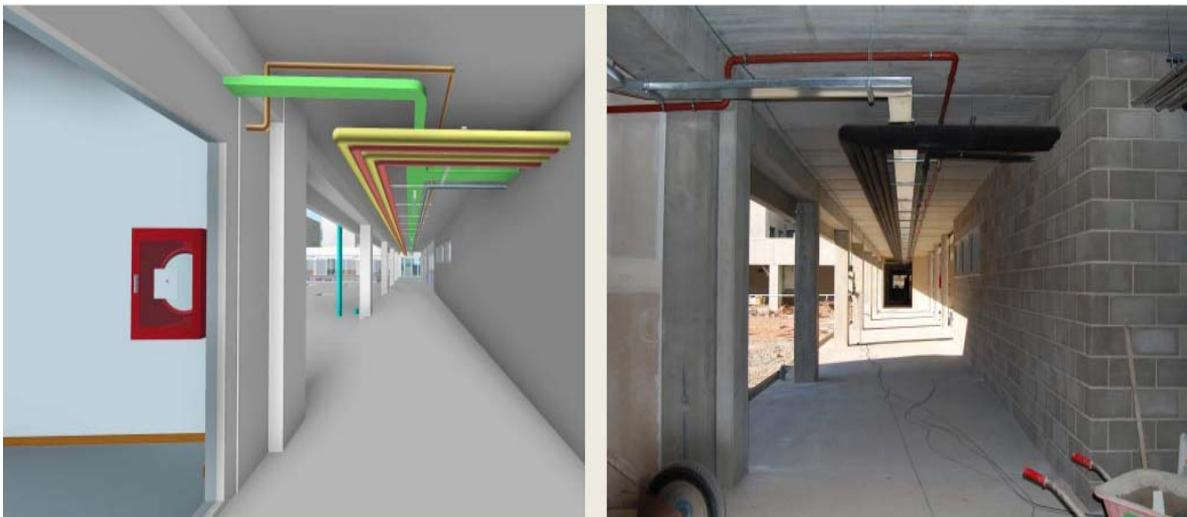
Fig. 3. Diseño y puesta en obra de instalaciones vistas
